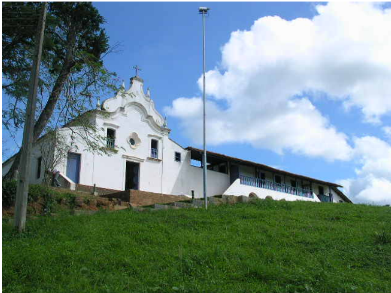
Casa-grande e Capela do Engenho Poço Comprido, após a última intervenção. Fonte: acervo da autora, 2005
